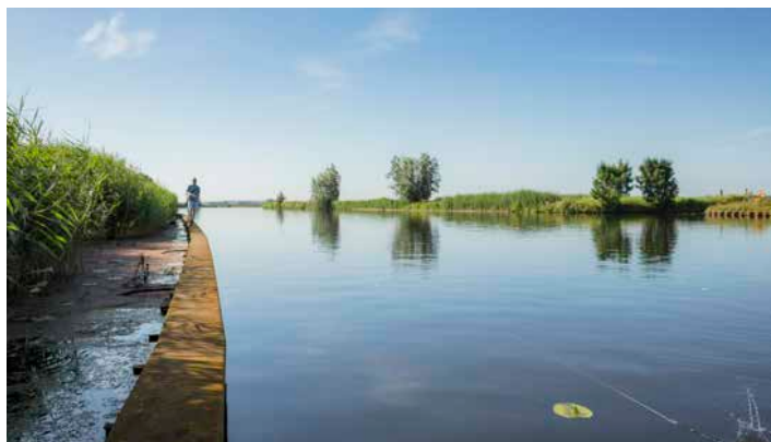
Een damwand biedt de mogelijkheid om brede rietkragen te omzeilen.
