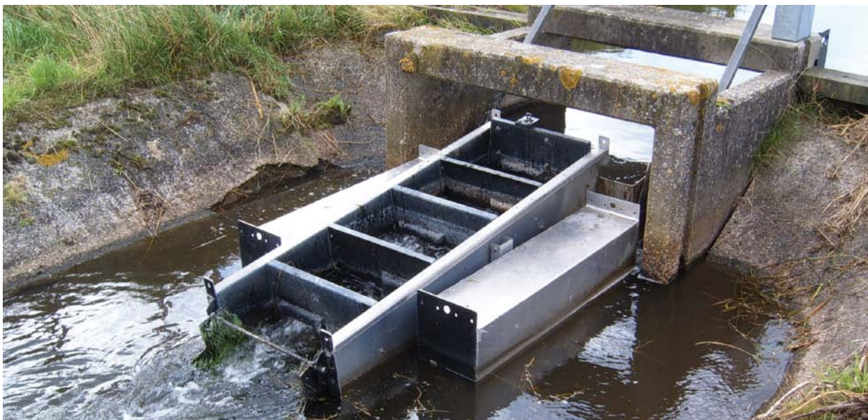
De vispassage in de Voorsterbeek: eenvoudig en toch goed werkend.
