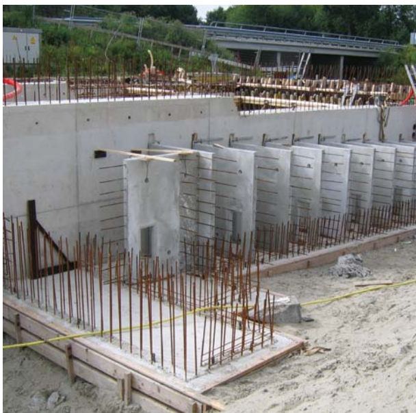
De aanleg van een Meyberg vispassage. De schotten met doorzwemopeningen zijn duidelijk te zien.
