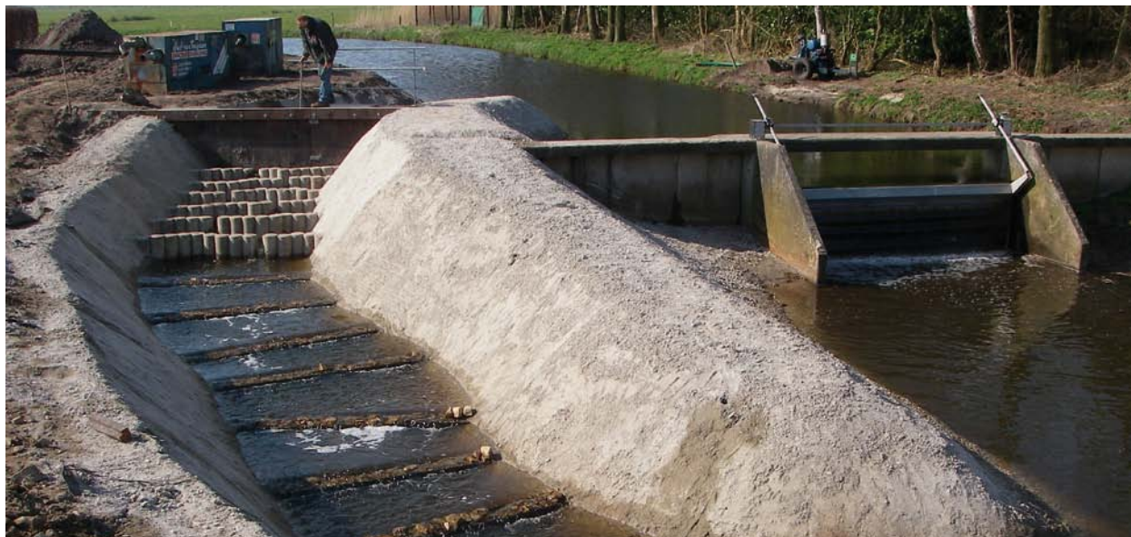
Een traditionele vistrap in aanleg.
