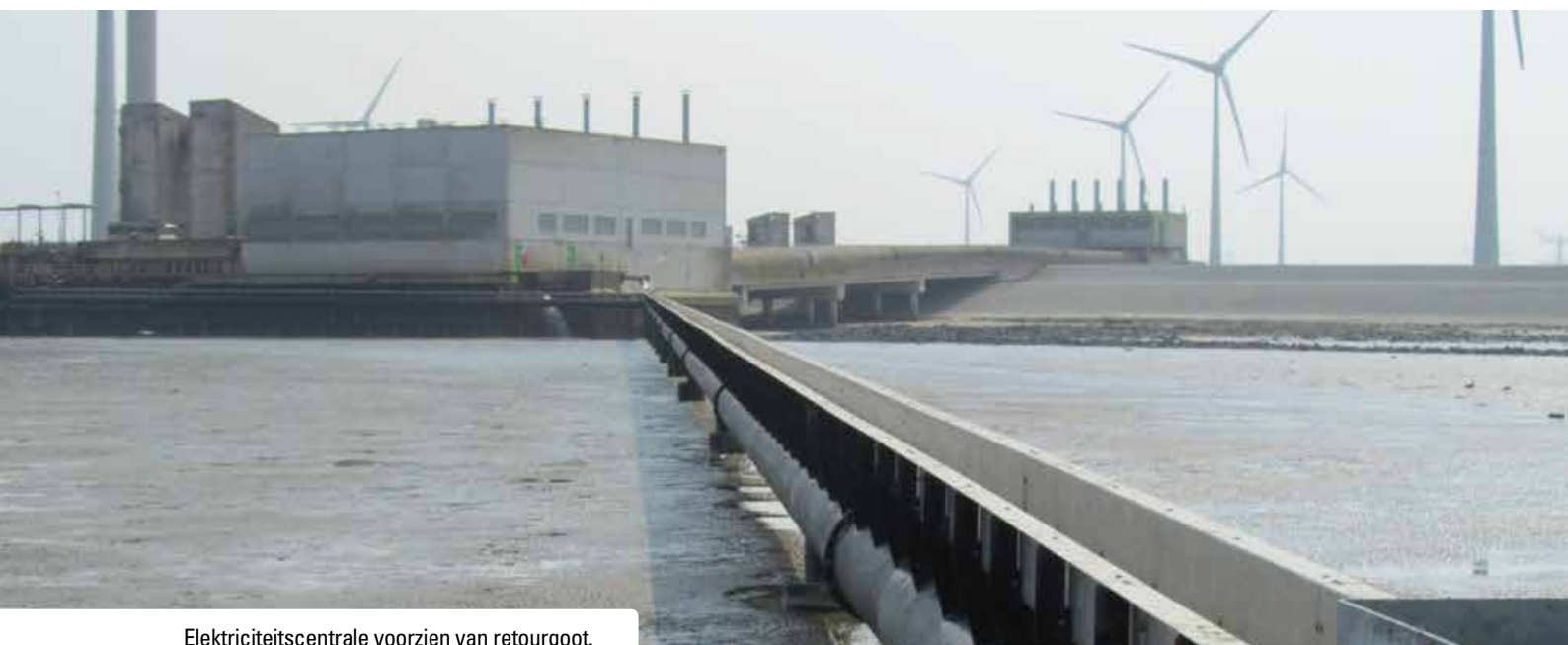
Elektriciteitscentrale voorzien van retourgoot.
